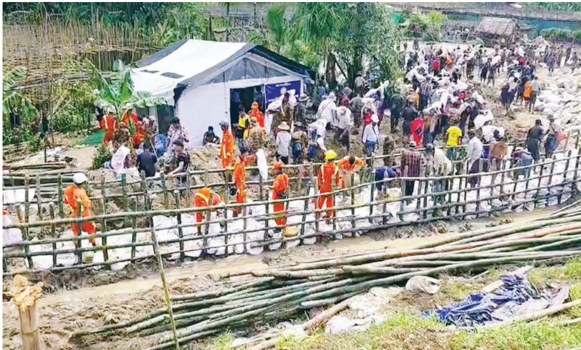
ညောင်တုန်းကျွန်းတာ(ရောဝတီမြစ်ခွဲ)၌ မြစ်ကမ်းပြိုမှုကြောင့် ရေကြီးရေလျှံမှုမဖြစ်စေရေး ကြိုတင်တားဆီးကာကွယ်ရေး လုပ်ငန်းများ ဆောင်ရွက်နေမှုကို တွေ့ရစဉ်။
