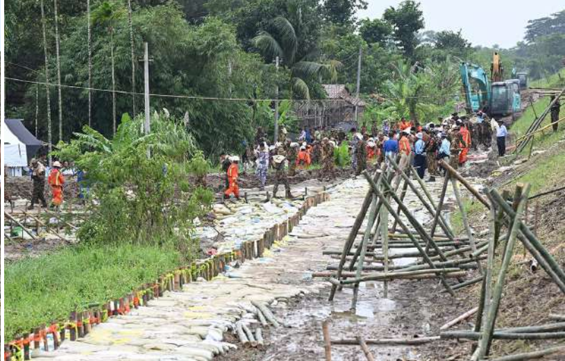
ဧရာဝတီတိုင်းဒေသကြီး ညောင်တုန်းမြို့နယ် ဂန်ချောင်းကျေးရွာအနီး ညောင်တုန်းကျွန်းတာ(ဧရာဝတီမြစ်ခွဲ) တာကိုယ်ထည်ရေတိုက်စားခံရမှု တားဆီးကာကွယ်ရေးလုပ်ငန်းများ ဆောင်ရွက်နေမှုကို တွေ့ရစဉ်။
