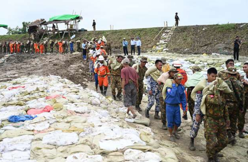
ဧရာဝတီတိုင်းဒေသကြီး ညောင်တုန်းမြို့နယ် ဂန်ချောင်းကျေးရွာအနီး ညောင်တုန်းကျွန်းတာ(ဧရာဝတီမြစ်ခွဲ) တာကိုယ်ထည်ရေတိုက်စားခံရမှု တားဆီးကာကွယ်ရေးလုပ်ငန်းများ ဆောင်ရွက်နေမှုကို တွေ့ရစဉ်။
