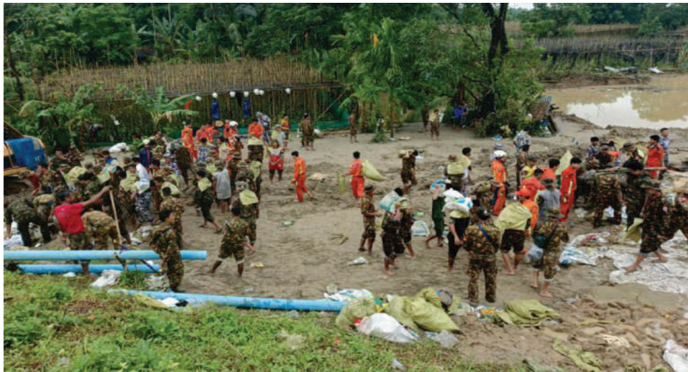
နယ်မြေခံတပ်မတော်သားများ၊ မြန်မာနိုင်ငံရဲတပ်ဖွဲ့ဝင်များ၊ လူမှုရေးအသင်းအဖွဲ့များနှင့် ဒေသခံပြည်သူများပူးပေါင်း၍ ညောင်တုန်းကျွန်းတာ(ဧရာဝတီမြစ်ခွဲ)တွင် တာကိုယ်ထည် ရေတိုက်စားမှုကာကွယ်ရန် တာခြေတွင် တုတ်တန်းရိုက် သဲအိတ်ဖြည့်ခြင်းလုပ်ငန်းများကို အင်တိုက်အားတိုက်ဆောင်ရွက်ကြစဉ်။
