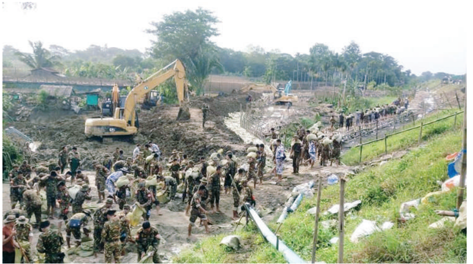
ညောင်တုန်းကျွန်းတာ(ဧရာဝတီမြစ်ခွဲ)၌ မြစ်ကမ်းပြိုမှုကြောင့် ရေကြီးရေလျှံမှုမဖြစ်စေရေး ကြိုတင် တားဆီးကာကွယ်ရေးလုပ်ငန်းများဆောင်ရွက်နေမှုကို တွေ့ရစဉ်။
