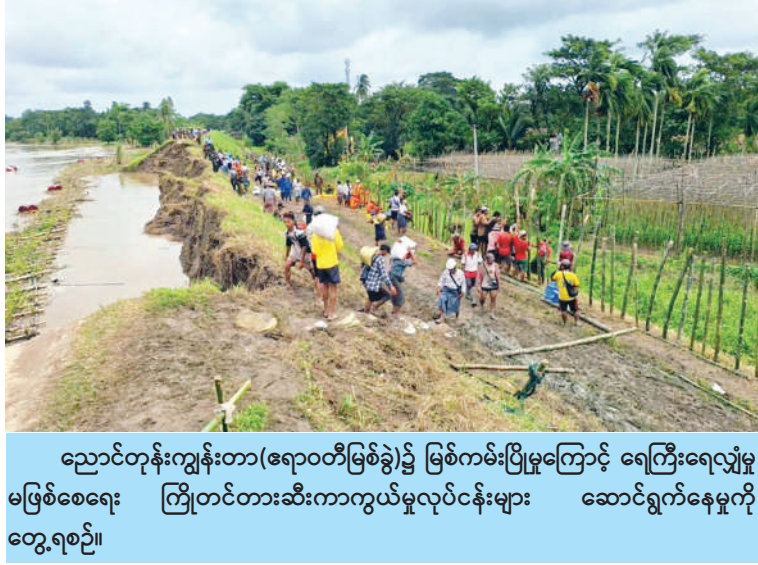
ညောင်တုန်းကျွန်းတာ(ရောဝတီမြစ်ခွဲ)၌ မြစ်ကမ်းပြိုမှုကြောင့် ရေကြီးရေလျှံမှု မဖြစ်စေရေး ကြိုတင်တားဆီးကာကွယ်မှုလုပ်ငန်းများ ဆောင်ရွက်နေမှုကို တွေ့ရစဉ်။
