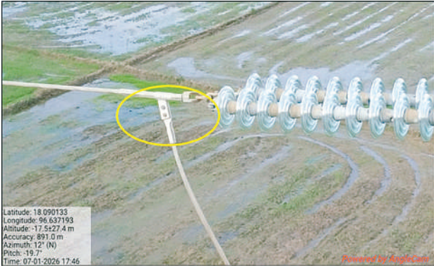
ကေဗီ ၂၃၀ ကွန်း - သာယာကုန်းဓာတ်အားလိုင်းတာဝါတိုင်အမှတ်(၁၂၉၊ ၁၃၀၊ ၁၃၁၊ ၁၃၆) Tension တိုင်များတွင် Jumper Connection Bolts & Nuts များ သံချေးစားနေသည်ကို စစ်ဆေးတွေ့ရှိရမှု မှတ်တမ်းဓာတ်ပုံ။
